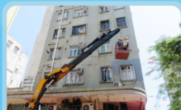
政府承建商為大埔區一幢目標樓宇進行緊急工程，移除外牆鬆脫部分
