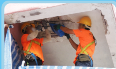
政府承建商為香港仔一幢目標樓宇進行緊急工程，移除外牆鬆脫部分
